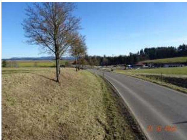
Foto 3: Nördlich der Rottweiler Straße gelegene Böschungstreifen mit Ahornbäumen
