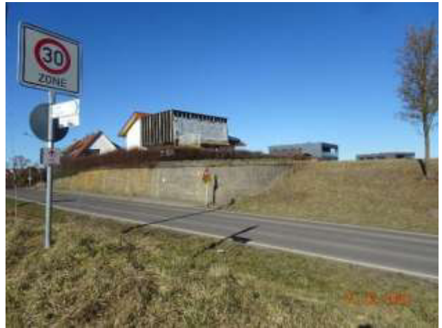
Foto 6: Stützwand aus Beton
